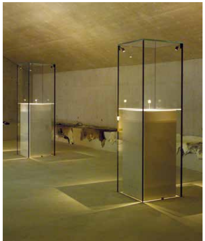
LED-Strahler in Glasecke platziert Kabelführung in der Klebefuge
